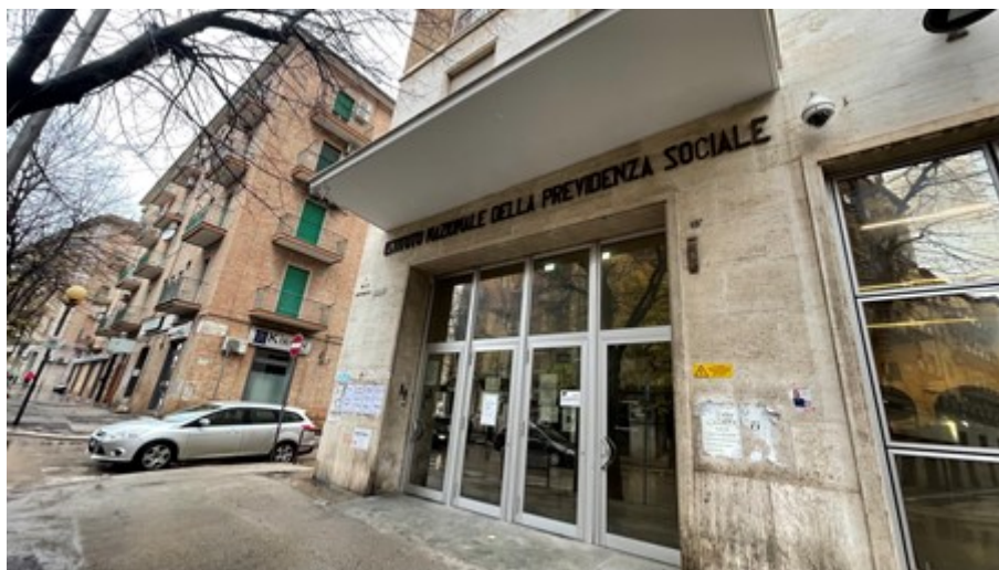
La sede Inps di Foggia*
