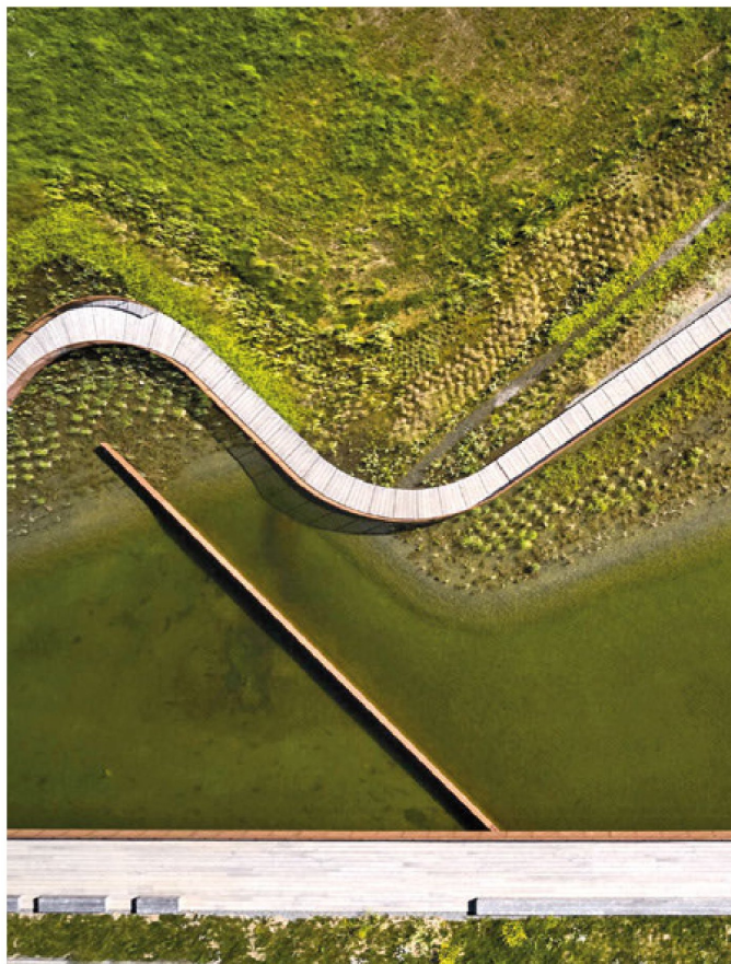
In Svezia, in un'ex area militare, un bacino per le acque piovane garantisce la depurazione dell'acqua e la protezione dalle inondazioni
