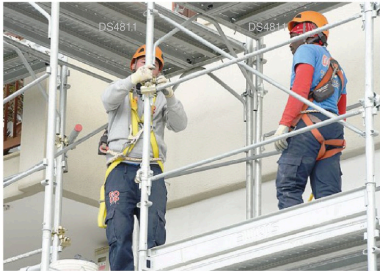
Cantieri. Cambiano le regole sulla sicurezza
