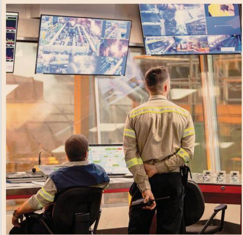
La sala di controllo. Il pulpito del laminatoio Ftm alla Tenaris di Dalmine
