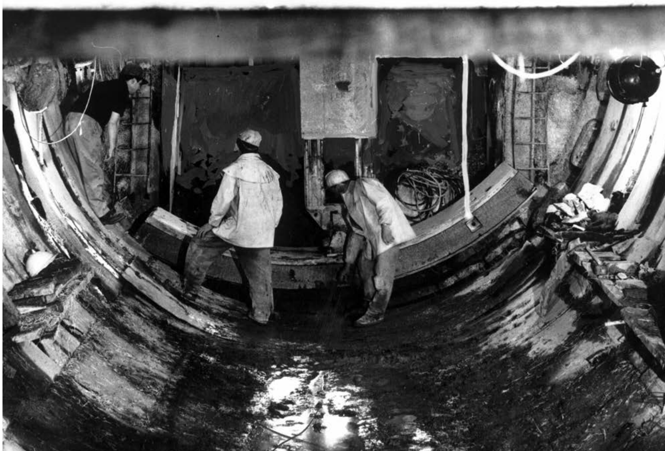
Costruzione di una galleria, ca. 1960 – Foto archivio fotografico Touring Club Italiano
