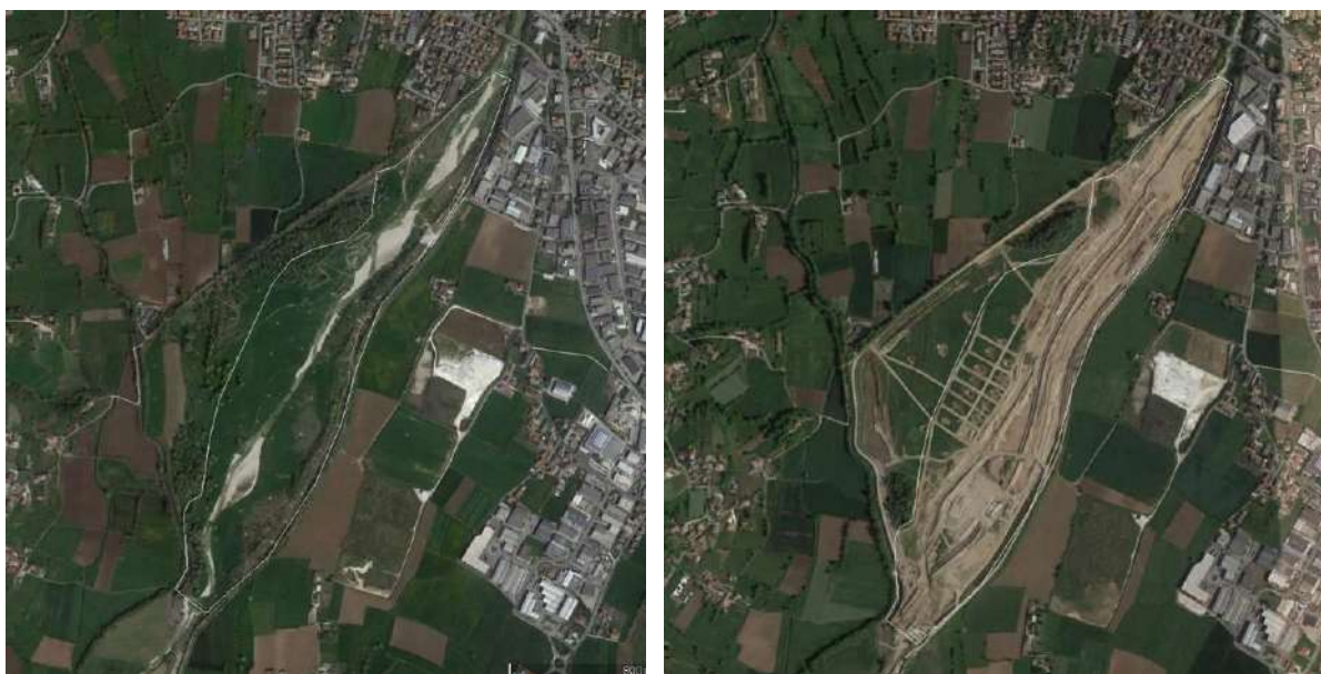
Figura 50 - Un bacino di laminazione del fiume Agno-Guà, con un invaso per 2,5 milioni di metri cubi ed esteso 49 ettari, è l'opera infrastrutturale per la mitigazione del rischio idrogeologico che ha spinto il Comune di Trissino (8.800 abitanti per un'area di 21 km 2 ), in provincia di Vicenza, al terzo posto dei comuni che nell'ultimo anno hanno maggiormente incrementato, rispetto al 2016, il loro consumo di suolo (51 ettari in totale).
