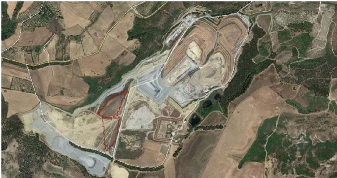
Figura 101 - L'ampliamento della cava sita nell'area di Crotona (3,5 ettari) ha occupato la quasi totalità del nuovo suolo consumato della città, pari a 4 ettari. La Calabria è la regione che nell'ultimo anno ha registrato uno degli incrementi più bassi nel Paese: appena 52 ettari impermeabilizzati complessivamente.
