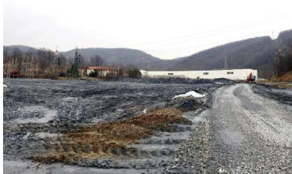
Figura 65 - Sito in preparazione per un nuovo insediamento industriale a Cairo Montenotte (Savona). Foto di Gianni Ciarlo.
