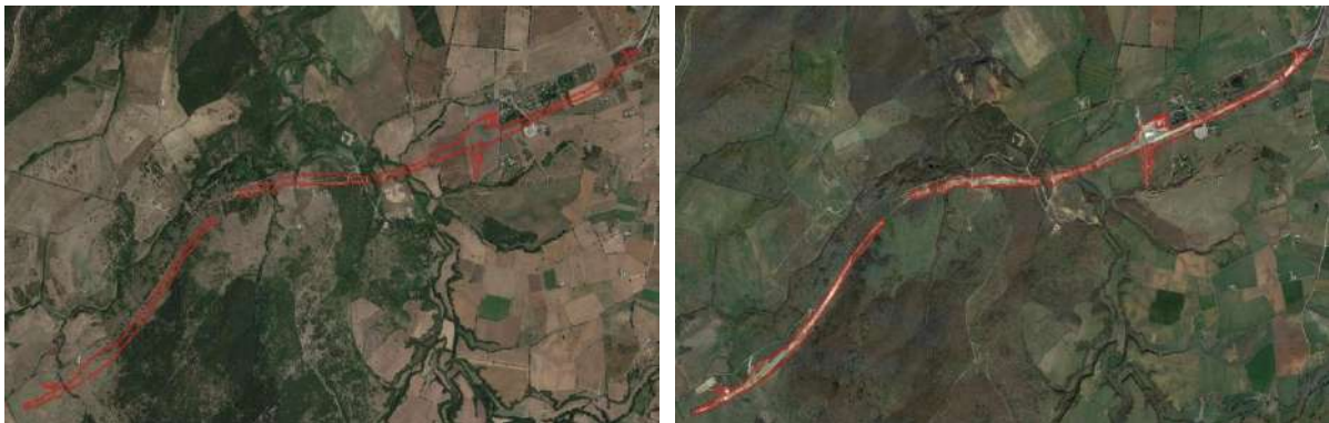
Figura 81 - Nuova bretella stradale nel territorio di Vetralla, Comune di 14.000 persone in provincia di Viterbo. La nascente infrastruttura è stata realizzata parallelamente alla Strada Statale 1bis Via Aurelia che conduce da Tarquinia a Vetralla e per il suo pieno sviluppo ha previsto una perdita di suolo pari quasi a 40 ettari tra il 2016 e il 2017.
