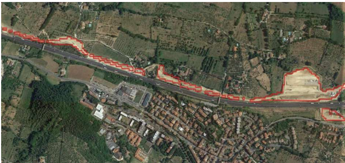
Figura 71 - L'avvio della realizzazione, tra il 2016 e il 2017, della terza corsia dell'autostrada A1 (l'Autostrada del Sole), nel Comune di Bagno a Ripoli (Firenze), ha comportato un consumo di suolo di oltre 8 ettari.
