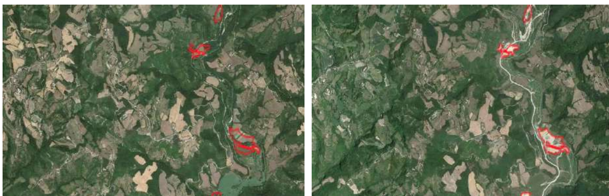
Figura 76 - Primo lotto della diga di Casanuova per sbarrare lo scorrimento del fiume Chiascio, allo scopo di creare, entro la fine del 2019, un serbatoio idrico per l'utilizzo agricolo. L'area si trova nel territorio di Gubbio, a confine tra il suo perimetro urbano e quello del contermino Comune di Valfabbrica (PG). Inoltre, nell'area più a valle, sono stati eseguiti importanti lavori di sterro all'interno dell'alveo fluviale.
