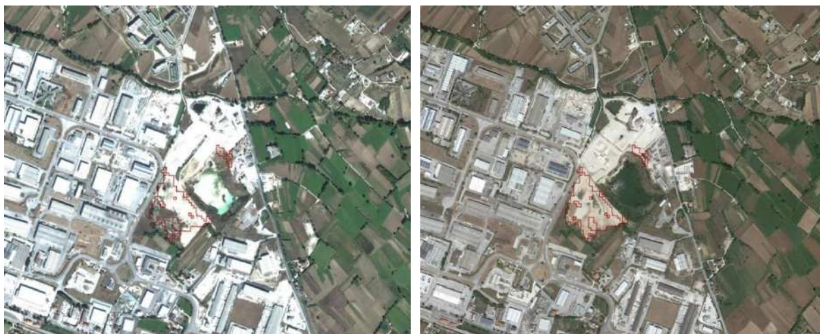
Figura 86 – Anche per l'ampliamento di un deposito di materiali edili da 25.000 m 2 , nei 474 km 2 de L'Aquila il consumo di suolo tra il 2016 e il 2017 è incrementato di 6,5 ettari. Nella Regione Abruzzo, nella quale sono stati documentati cambiamenti per 117 ettari, L'Aquila è il primo Comune.
