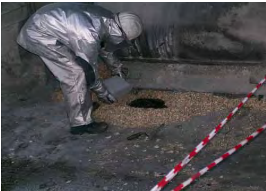
Foto n. 8 – Si inertizza la sostanza nel vano sottostante alla bascula mediante olio minerale
