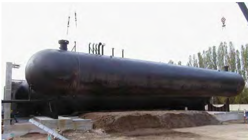
Fotografia n° 1 – Momento posa serbatoio D06
