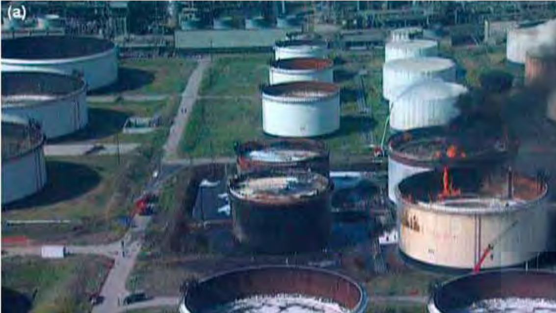
Figura 10 - Terremoto Kocaeli – Turchia del 17/08/1999. Raffineria Tupras di Izmit. Incendio serbatoi benzina
