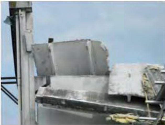
Figure 8, 9 – Caduta laterale della trave
