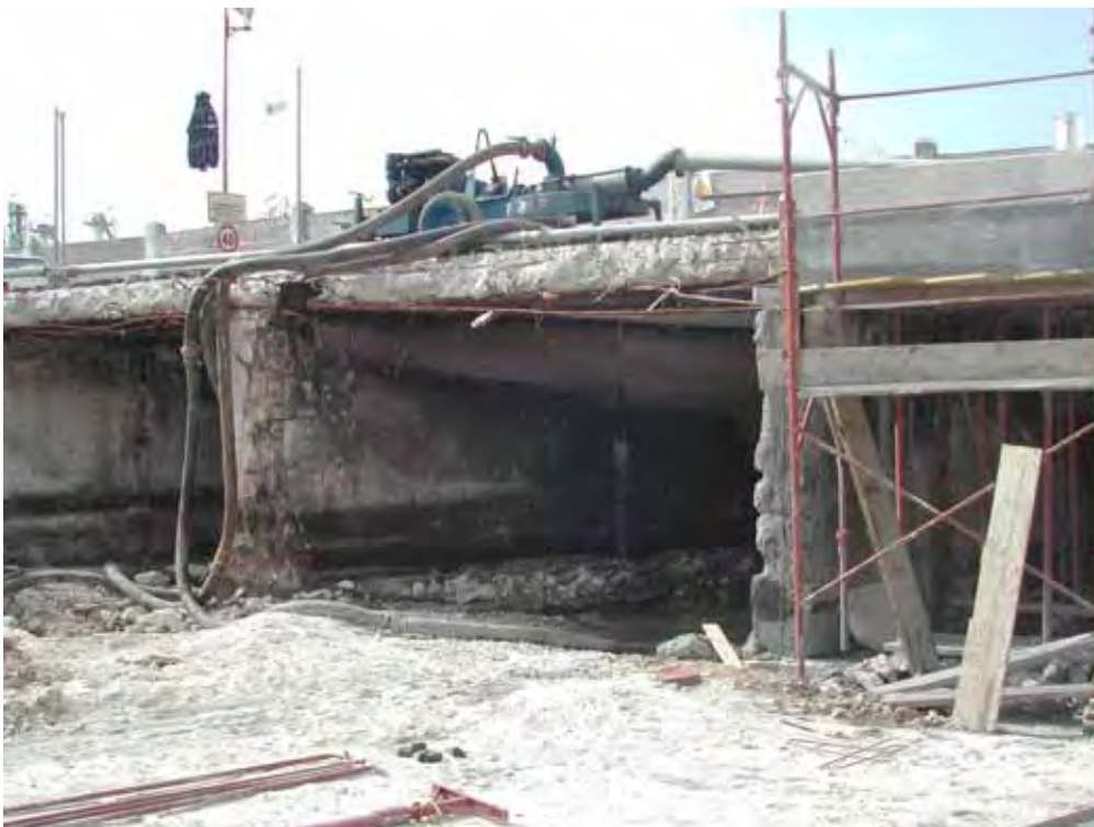
Foto n. 9 – Lavori di ristrutturazione dei cunicoli del sottopasso
