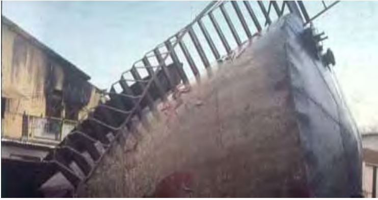
Figura 8 – Ribaltamento di un serbatoio
