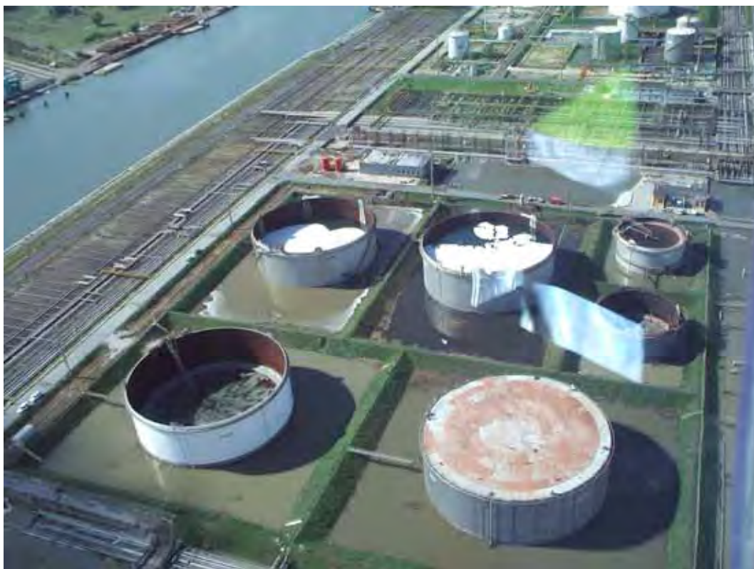
Fig 1 Veduta aerea del parco serbatoi sud e dei serbatoi interessati dall'affondamento del tetto galleggiante (con schiuma interna)
