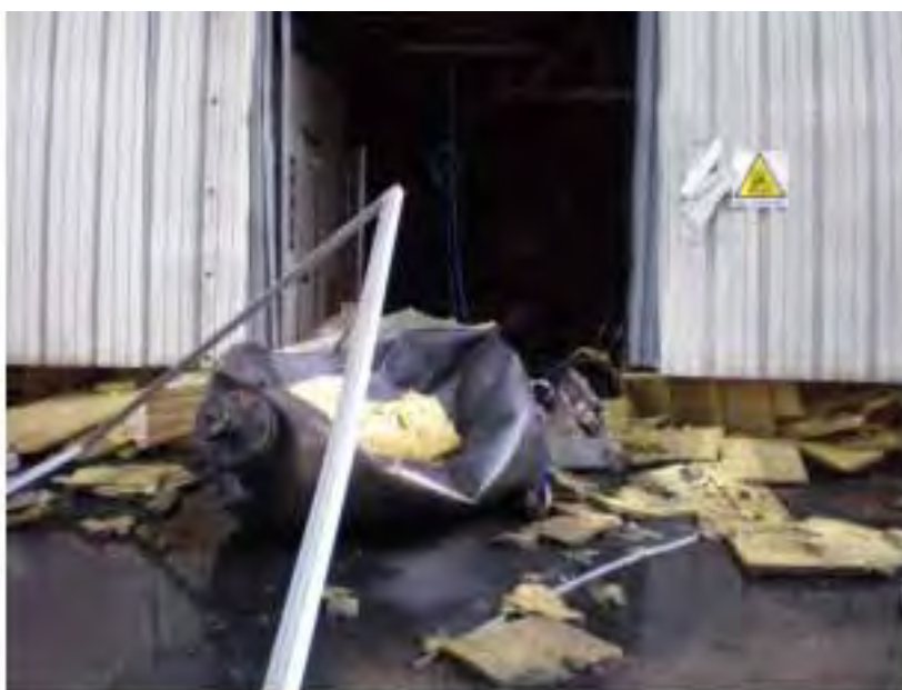
Figura 2. Spostamento di un serbatoio per l'onda di pressione della reazione runaway
