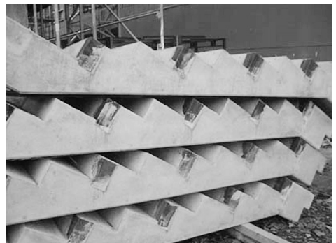
Abb. 17: Lagerung von Fertigteiltreppen
