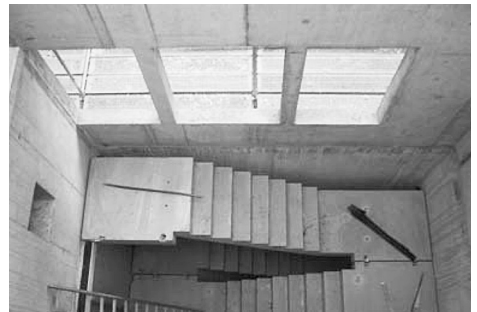
Abb. 19: Montage einer Fertigteilertreppe
