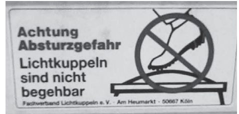
Abb. 20: Kennzeichnung einer Lichtkuppel
