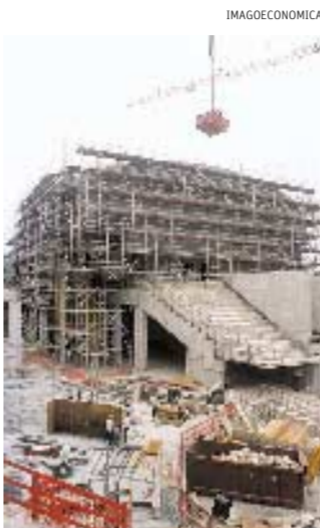
In cantiere. Più occupati in edilizia
