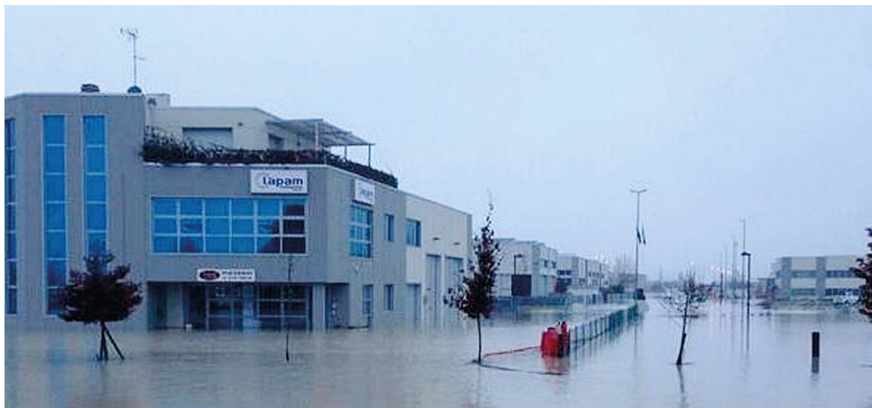
Sott'acqua non solo le case ma anche i campi agricoli e gli insediamenti artigianali e industriali: danni incalcolabili, in attesa di vere strategie di prevenzione
