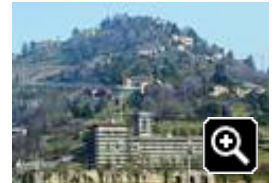
Il cantiere della General Casa per il recupero del monastero di Astino
